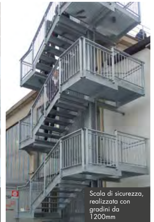
Scala di sicurezza, realizzata con gradini rinforzati da 1800mm
