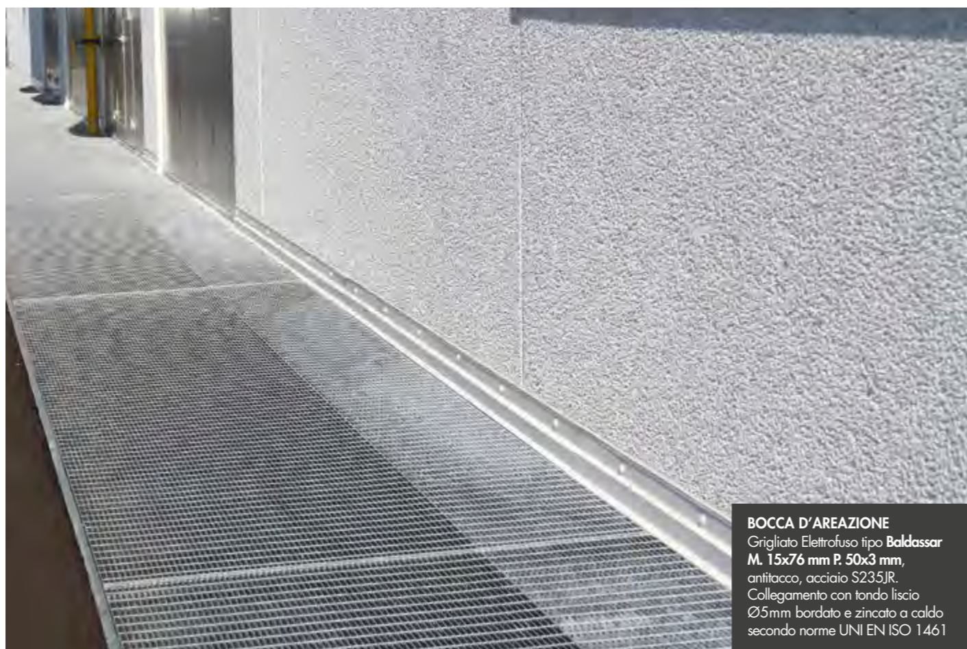
BOCCA D'AREAIONE Grigliato Elettrofuso tipo Baldassar M. 15x76 mm P. 25x2 mm , antitacco, acciaio S235JR. Collegamento con tondo liscio Ø4mm bordato e zincato a caldo secondo norme UNI EN ISO 1461
