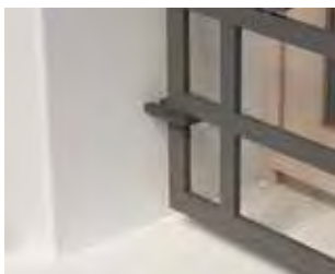
Supporto di fissaggio per inferriata interna in lamiera.
